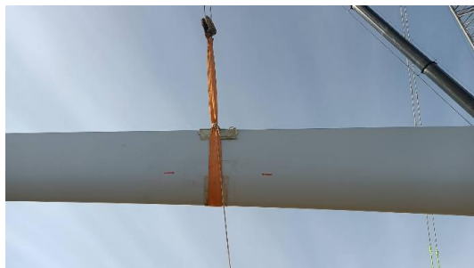
图 15-5 安装溜尾吊具
