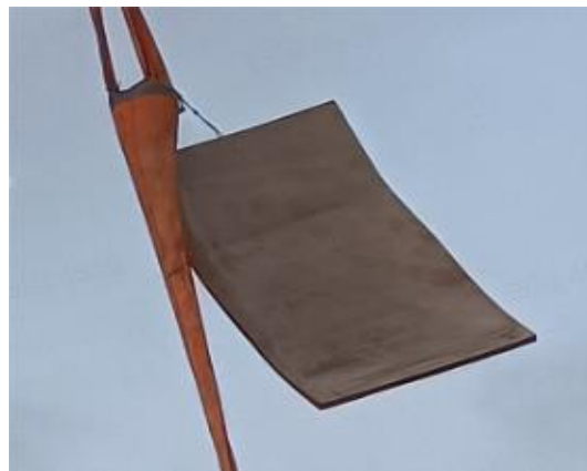
图 14-29 安装叶片护垫
