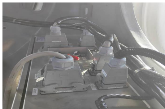
图 14-15 变桨系统供电（A0X1）
