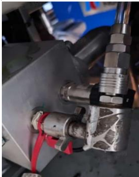
图 12-39 安装补液工装
