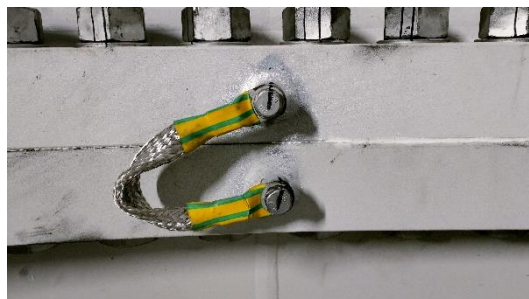
图 9-21 安装塔筒间防雷接地线
