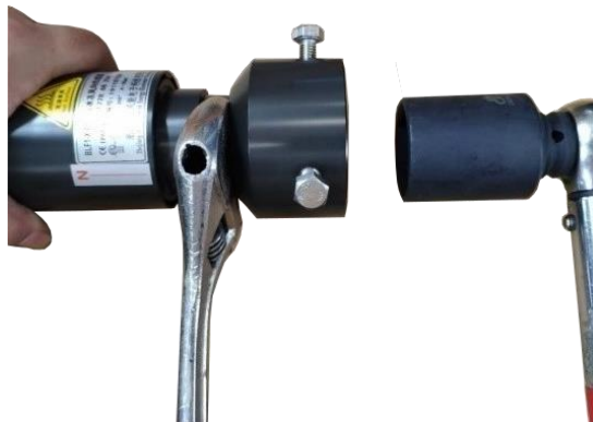
图 13-28 紧固风速仪
