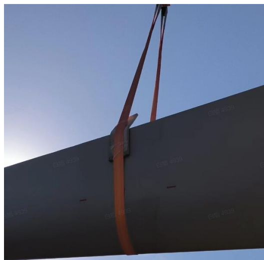
图 14-24 安装第一支叶片
