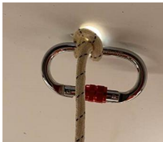
图 11-4 塔筒上端扰流条固定（内部）
