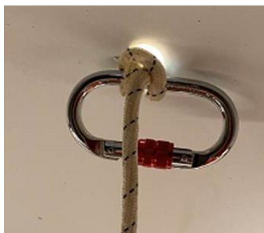
图 11-8 塔筒下端扰流条固定
