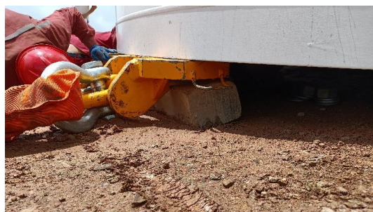
图 9-7 拆除下法兰吊具
