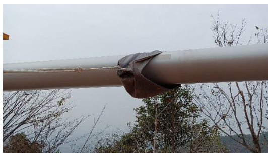
图 14-31 安装叶尖护套（不带降噪齿叶片）
