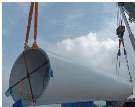
图 7-6 塔筒卸车（方案二）
