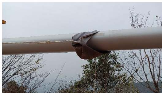
图 14-19 安装叶尖护套（不带降噪齿叶片）
