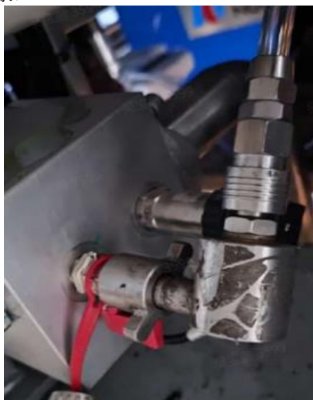
图 13-47 安装补液工装
