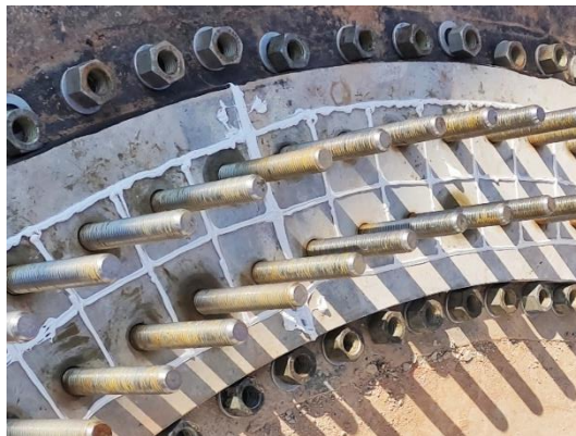
图 9-5 基础上锚板间隙涂密封胶
