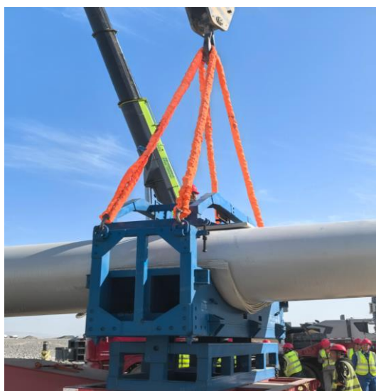
图 7-17 安装叶片吊具（双车）
