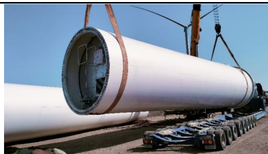
图 7-5 塔筒卸车（方案一）
