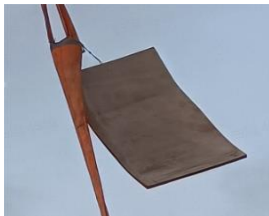
图 14-23 安装叶片护垫
