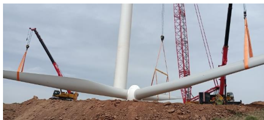
图 14-35 安装第三支叶片
