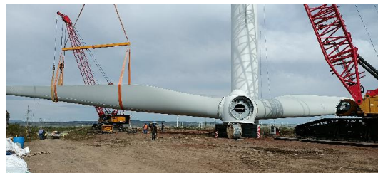
图 14-30 安装第二支叶片
