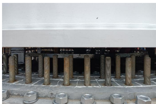
图 9-10 塔筒与基础对接
