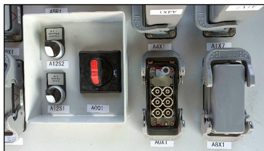
图 14-16 变桨操作旋钮
