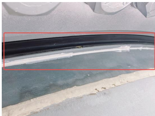
图 7-38 叶片法兰与变桨轴承外部缝隙涂胶
