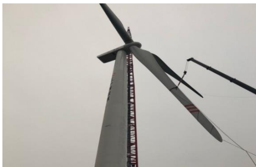
图 15-11 副起重机拉拽溜尾叶片
