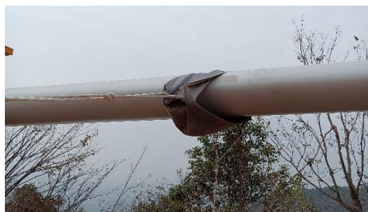
图 14-25 安装叶尖护套（不带降噪齿叶片）
